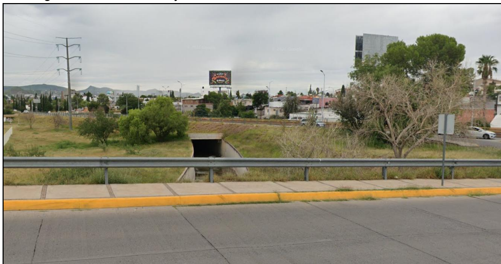
Imagen 41. Vista del arroyo La Cantera, con cauce confinado a cielo abierto.
