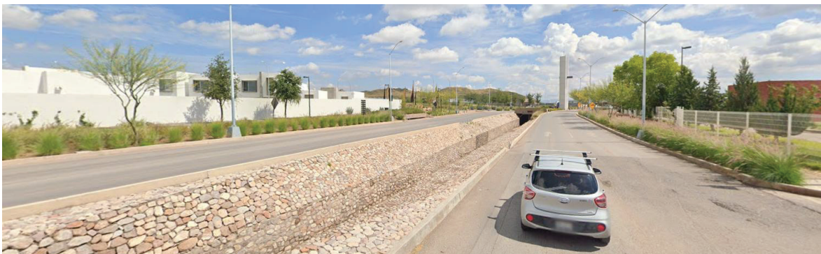
Ilustración 33. Arroyo Los Temporales, vista desde el Fracc. Monte Verde. Fuente: Google Earth, 2025.
