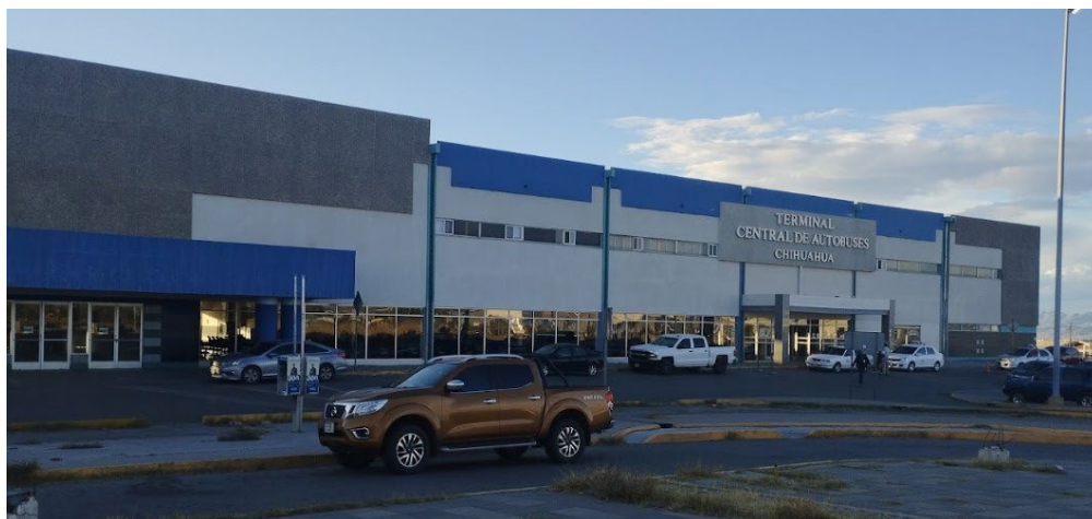
IMAGEN 36.- Instalaciones Central de Autobuses de Chihuahua. Fuente: Elaboración propia.
