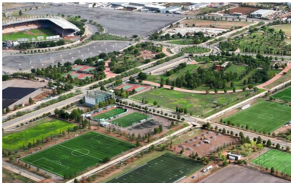
IMAGEN 45.- Instalaciones Deportiva Sur. Fuente. El Heraldo de Chihuahua.
