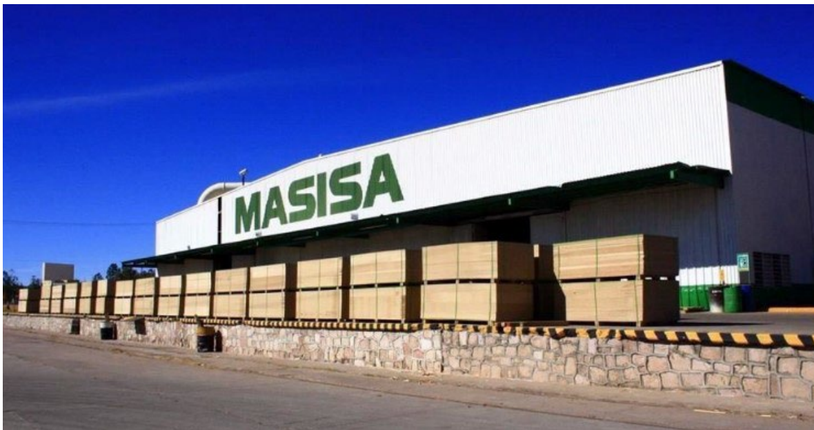
IMAGEN 47.- Empresa Masisa Industrial localizada en la zona. Fuente. Elaboración propia.
