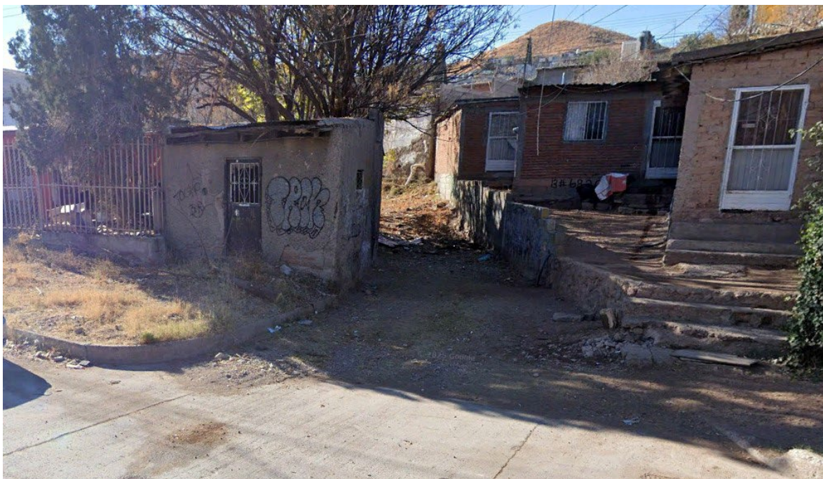
IMAGEN 95.- Esguerrimiento pluviol en la calle 13ª. Fuente: Elaboración propia.
