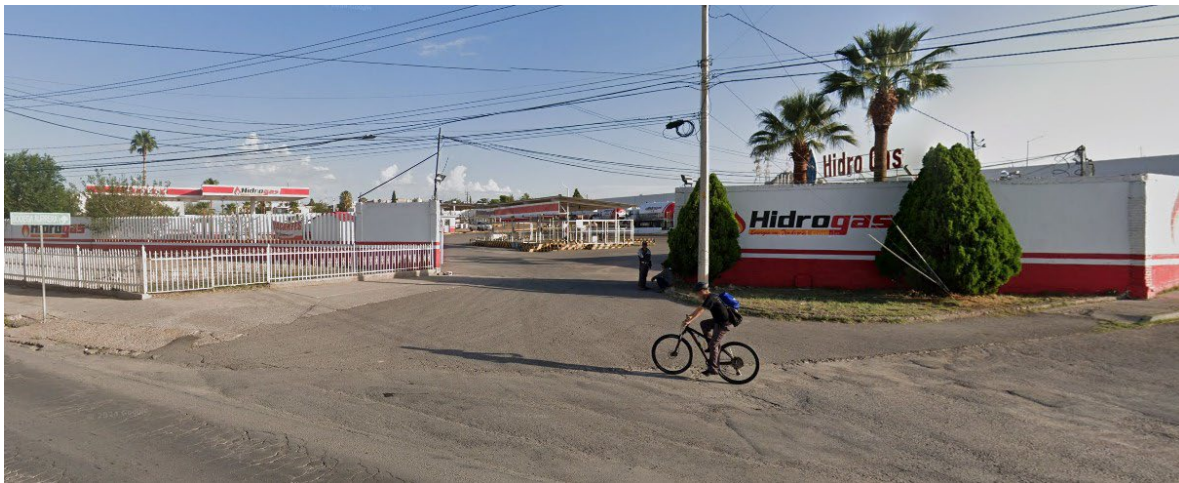
IMAGEN 159.- Instalaciones gasera Hidrogas. Fuente: Elaboración propia.
