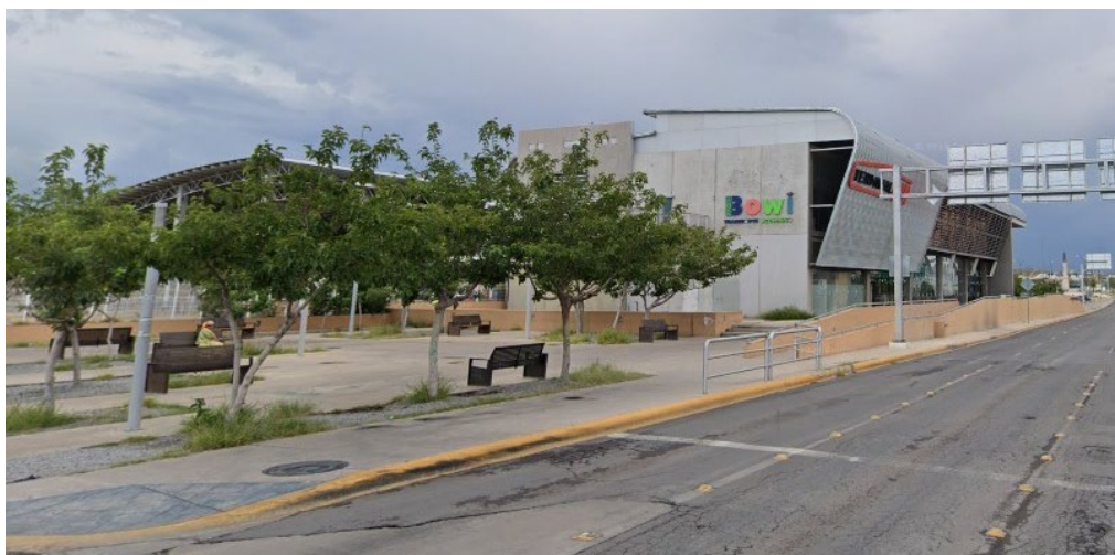
IMAGEN 37.- Terminal Sur Bowi. Fuente: Elaboración propia.
