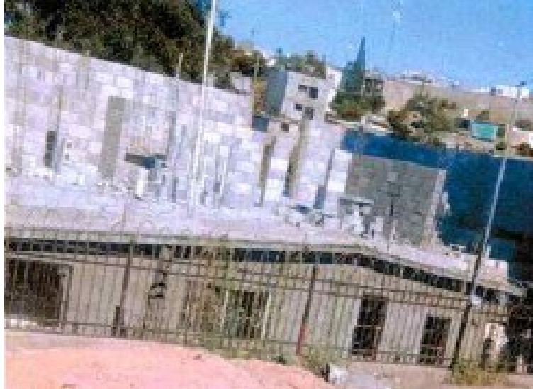
IMAGEN 186.- Construcción en el área de aplicación. Fuente: Elaboración propia.
