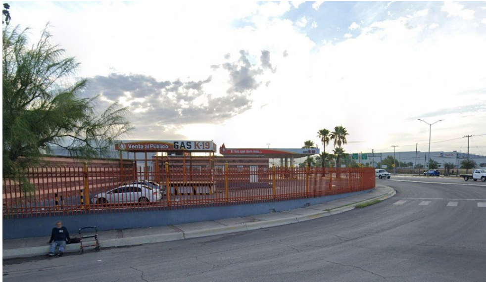
IMAGEN 158.- Instalaciones gasera K-19. Fuente. Elaboración Propia.
