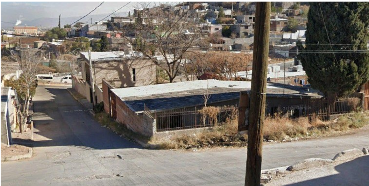
IMAGEN 87.- Pendiente hacia las vías del FFCC de la vialidad colindante al área de aplicación. Fuente: Elaboración propia.
