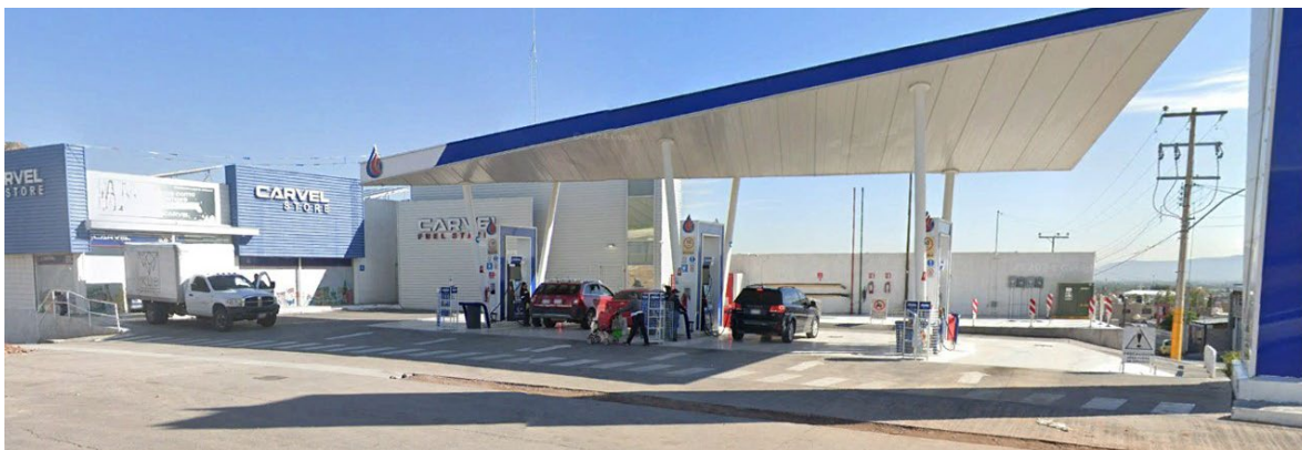
IMAGEN 166.- Instalaciones gasolinera Carvel. Fuente: Elaboración propia.
