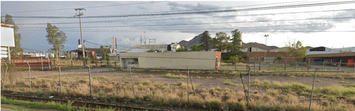
IMAGEN 163.-Instalaciones abandonadas que señalaba el Atlas de Riesgo como riesgo medio. Fuente: Elaboración propia.
