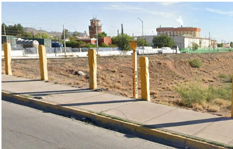
IMAGEN 156.- Señalización de Gasoducto. Fuente: Elaboración propia.
