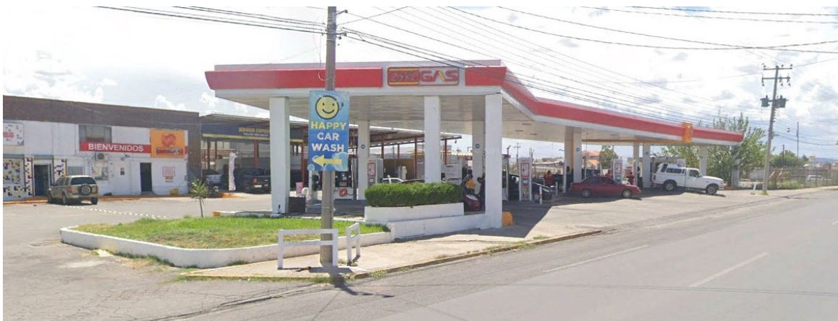
IMAGEN 168.- Instalaciones gasolinera Oxxo Gas. Fuente: Elaboración propia.
