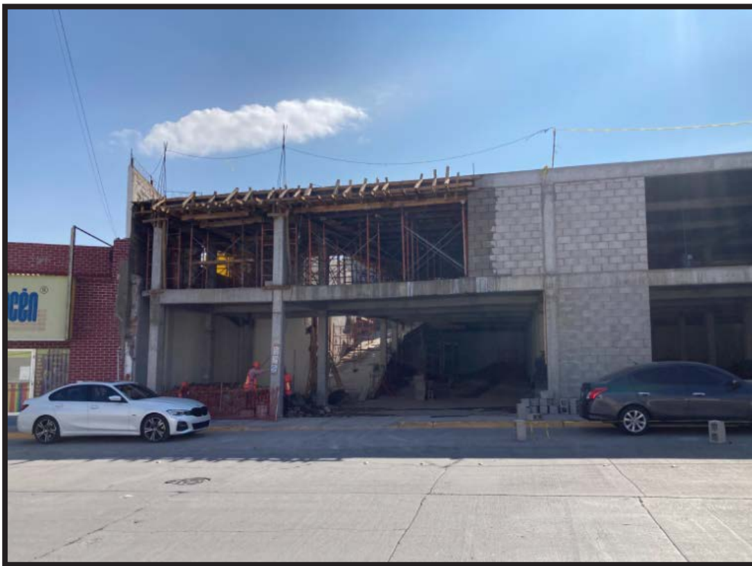
Ejemplo de obra en proceso en av. Ocampo esquina con Calle Jose Esteban Coronado
