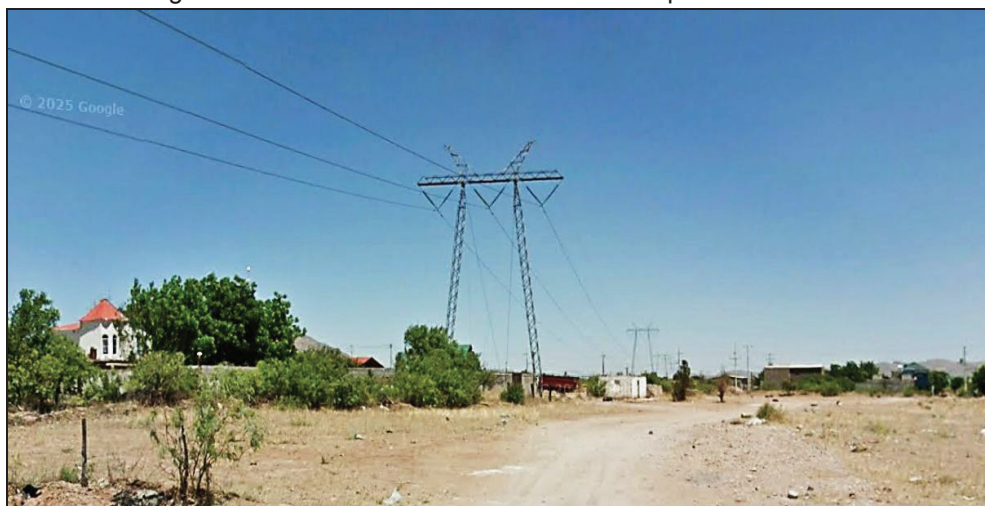
Imagen 83. Vista de infraestructura cercana al predio de estudio.
