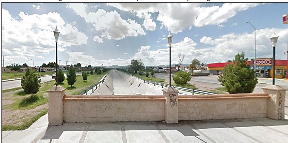
Imagen 74. Infraestructura pluvial del Arroyo Nogales norte.
