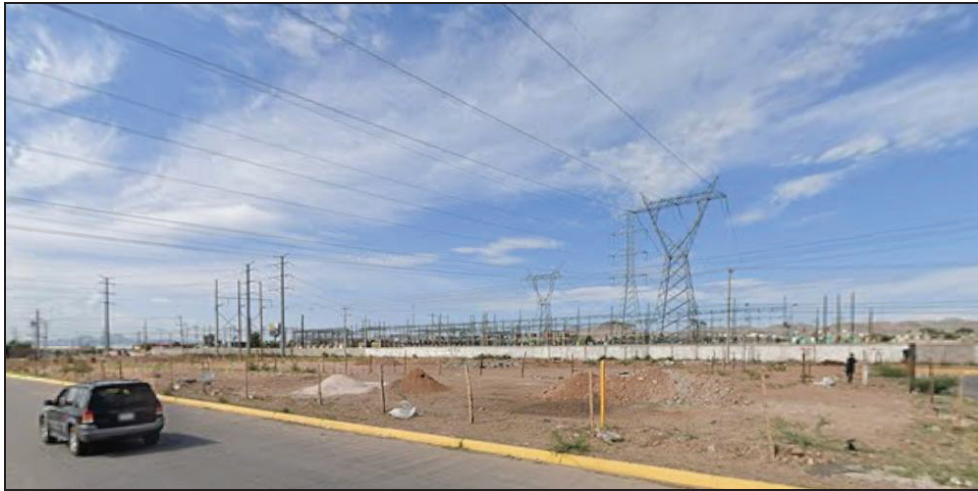
Imagen 65. Vista de subestación eléctrica al sur del polígono de análisis.
