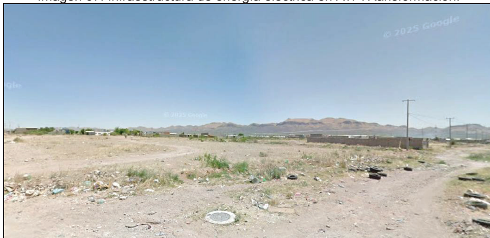
Imagen 67. Infraestructura de energía eléctrica en Av. TRansformación.
