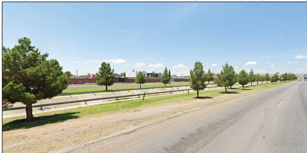
Imagen 9. Desalojo pluvial sobre la Vialidad Los Nogales, al arroyo Nogales norte.
