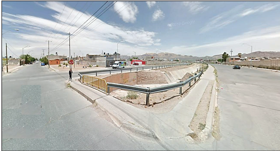
Imagen 69. Desalojo pluvial sobre la Vialidad Los Nogales, al arroyo Los Arcos.
