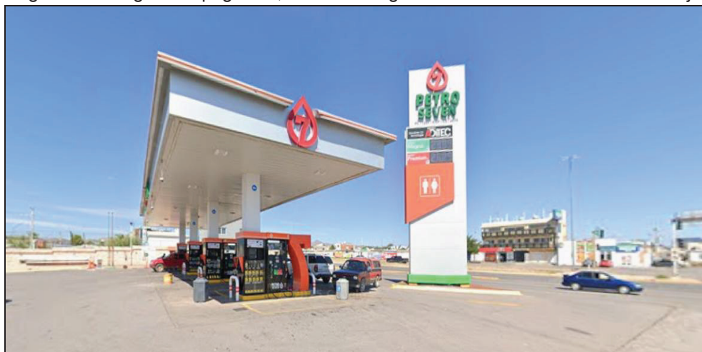
Imagen 76. Riesgo antropogénico, estación de gasolina en Av. Guillermo Prieto Lujan.
