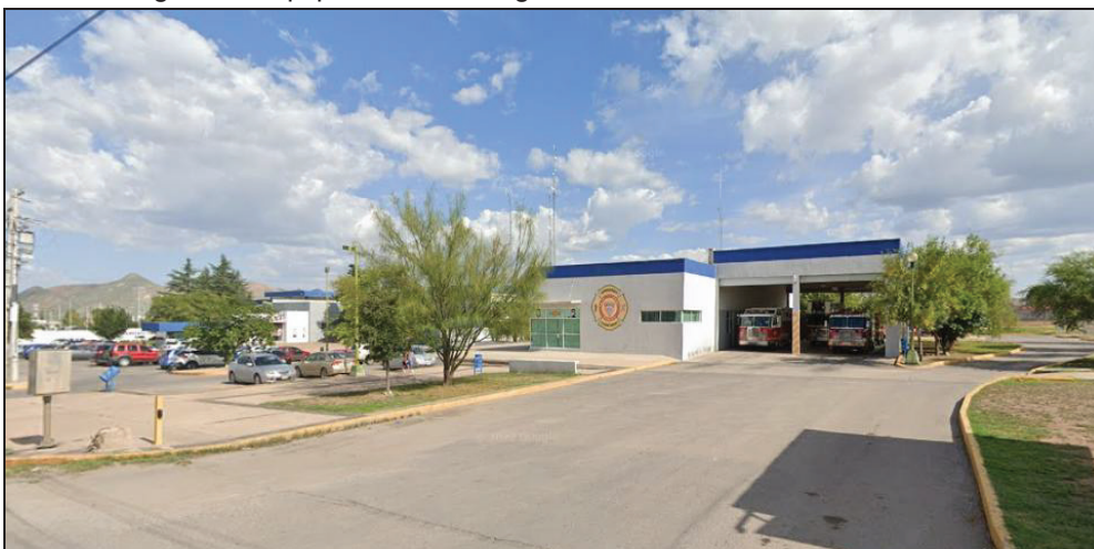
Imagen 38. Equipamiento de seguridad, Estación de Bomberos No. 3.
