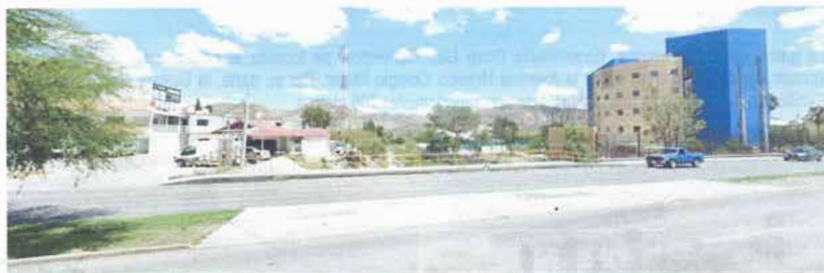
Imagen 73. Arroyo El Mimbres Sur. Fuente: Google Earth, octubre 2025.
