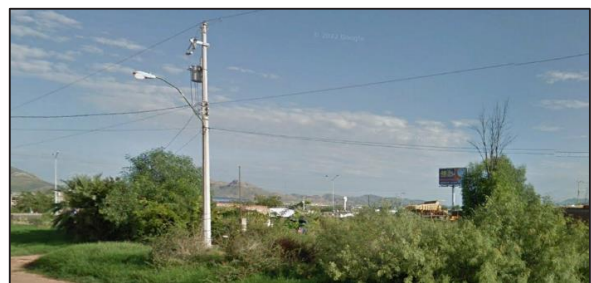
Infraestructura de energía eléctrica y alumbrado público
