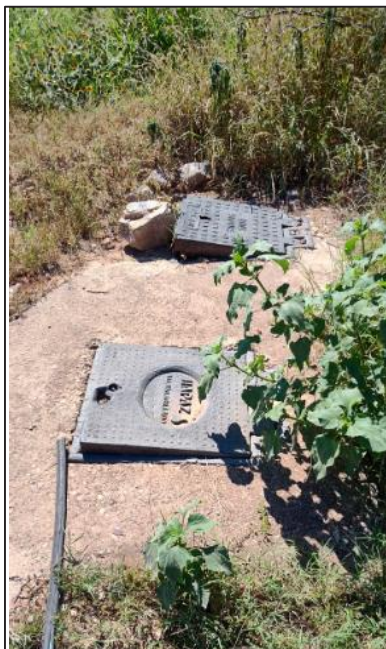
Foto: Registros de agua potable y drenaje de la JMAS, en calles 91 y 15 frente al predio en estudio.
