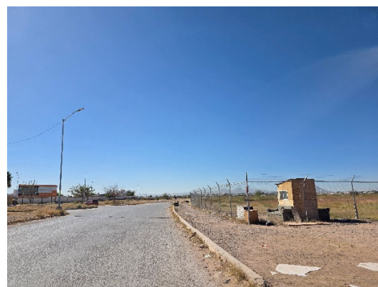
Imagen 13. AV. CENTRAL colindante al predio. Elaboración propia.
