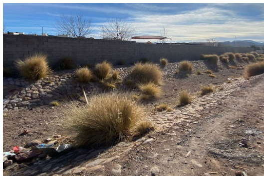
Imagen 13. Arroyo “El Cacahuatal” revestido ubicado en la parte posterior del área de estudio. Elaboración propia.
