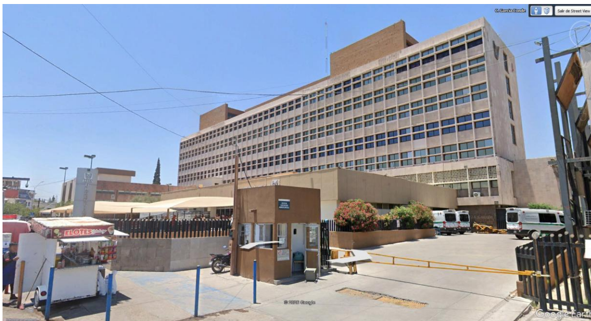
Instalaciones del IMSS, Hospital Morelos Chihuahua Fuente Google Earth Pro 2026
